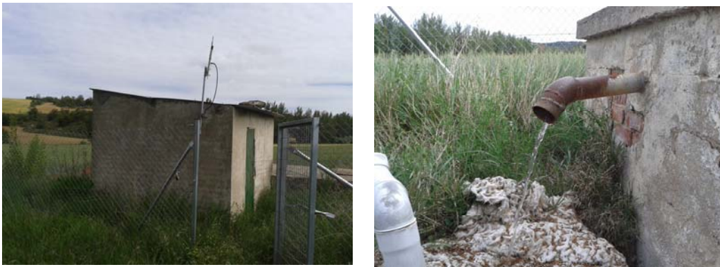
Caseta de captación del Manantial El Tornero
