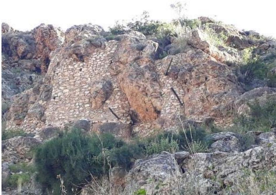
**Figura 31.** Ejemplo de muro de revestimiento sobre talud rocoso para protección. Suele llevarse a cabo con piedra de la zona. Fotografía tomada en la localidad de Ayna (Albacete)
