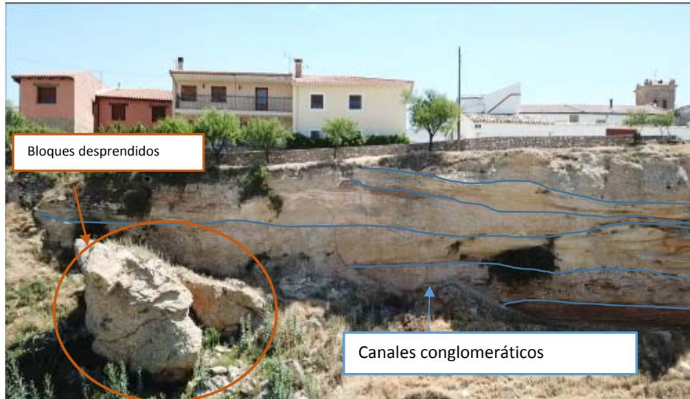
**Figura 27.** Sustrato de apoyo de la localidad de Cuevas de Velasco. Al pie de este escarpe existen variedad de bloques desprendidos a causa de falta de soporte de las capas inferiores que han sido descalzadas por acción erosiva
