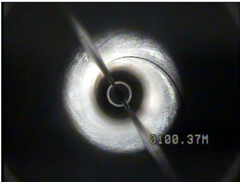
Buen estado de la entubación, 100 m
