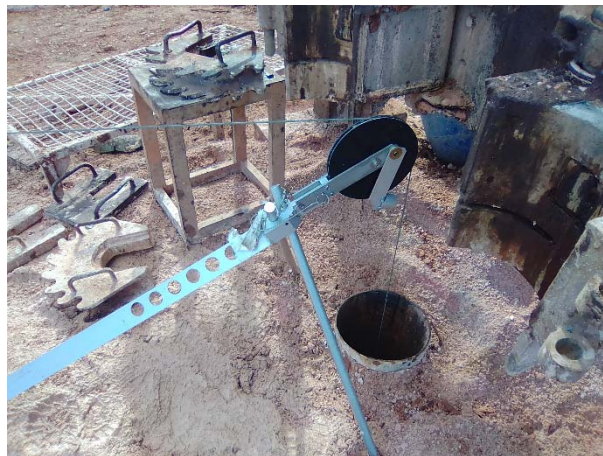
Figura 13. Desarrollo de los trabajos
