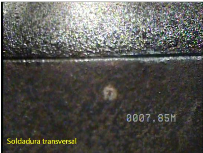
Soldadura transversal, 7,85 m
