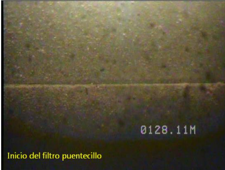
Inicio del tramo filtrante 1, 128,11 m
