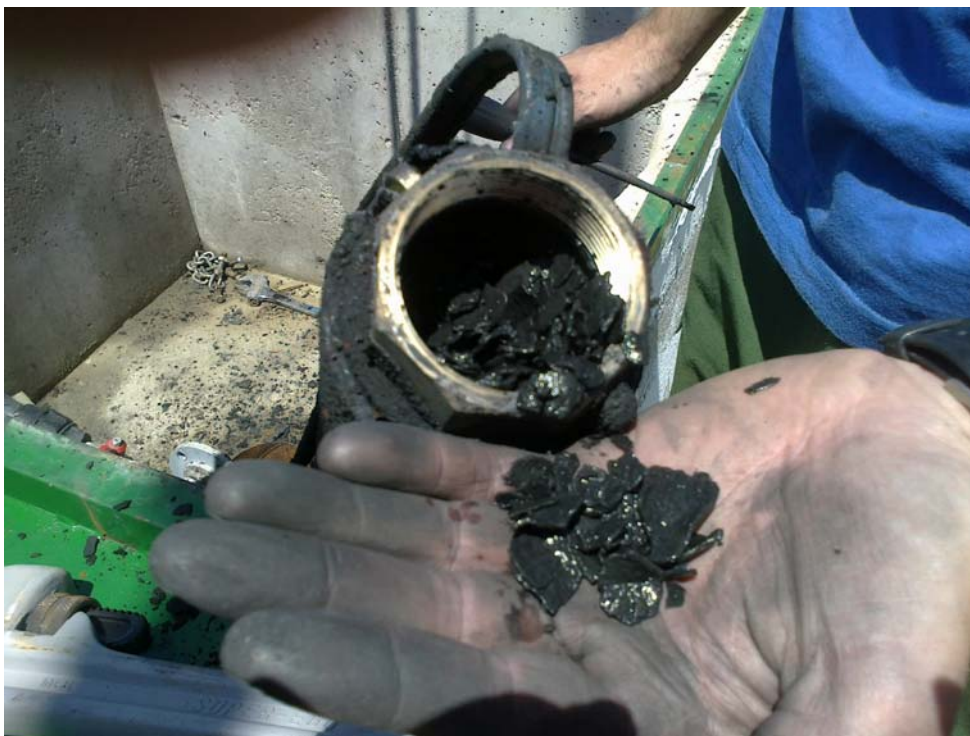
Figura 4. Detalle del estado de la bomba del sondeo.
