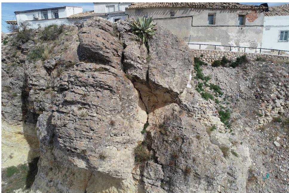
**Figura 27.** Fotografía en la que se observan en detalle las discontinuidades o grietas verticales que definen el bloque en voladizo. Obsérvese la apertura y gran continuidad de las mismas y la cicatriz, roca más clara en sombra, que dejó en la pared la caída de un bloque anterior
