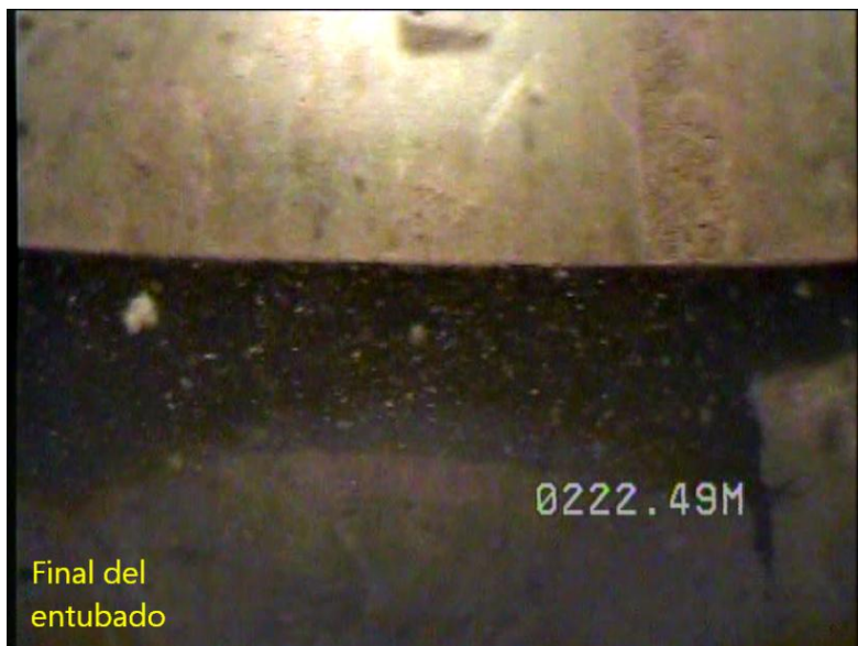
Final del entubado, 222,49 m
