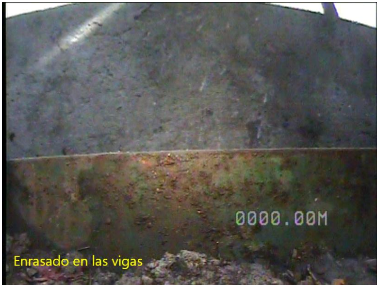
Enrasado en las vigas, 0 m
