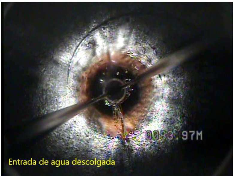
Entrada de agua descolgada, 84 m
